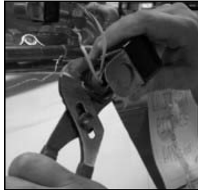
Loosening the conduit nut
